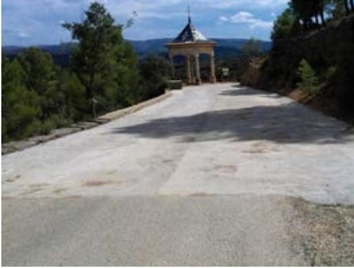
media, la segunda también de 23 m de longitud y 5,8 m de altura media. En la Balma, además, se repuso el firme en la zona de los trabajos mediante losas de hormigón. Por su parte, en el cementerio se reconstruyeron 60 m de muros de mampostería anexos a la escollera, y se construyó una losa de hormigón.
