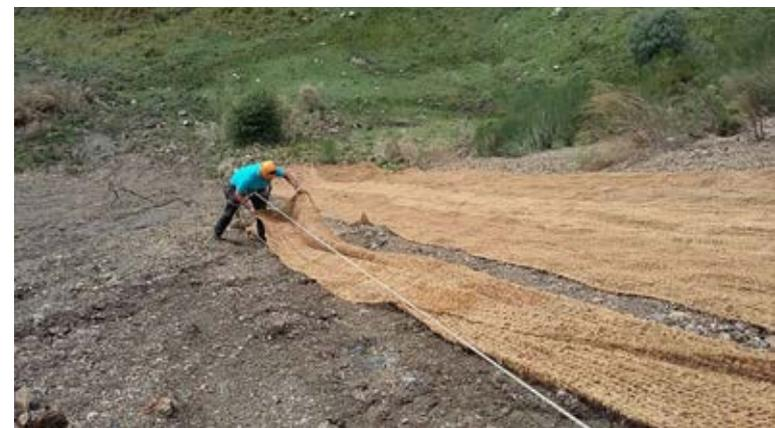
ambiental para la fauna silvestre, además de emplearse materiales de acuerdo con las especificaciones del pliego, que no supusieran impacto ambiental negativo, ni por su composición ni visualmente. En la estabilización del terreno se empleó la técnica de sujeción mediante malla de coco que asegura las condiciones medioambientales descritas.
