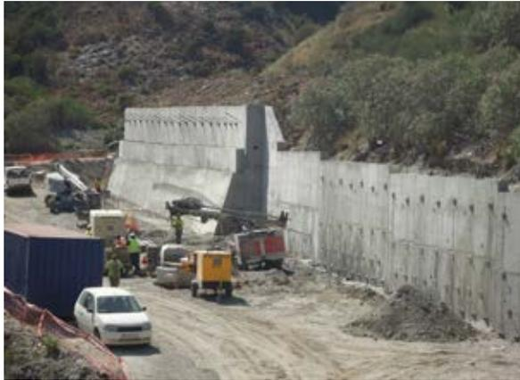
de mechnales y tubos drenantes mediante la ejecución de drenes californianos; ejecución de un terraplén auxiliar para el apoyo de la máquina de pilotes; y la ejecución y gunitado de la pantalla de pilotes.
