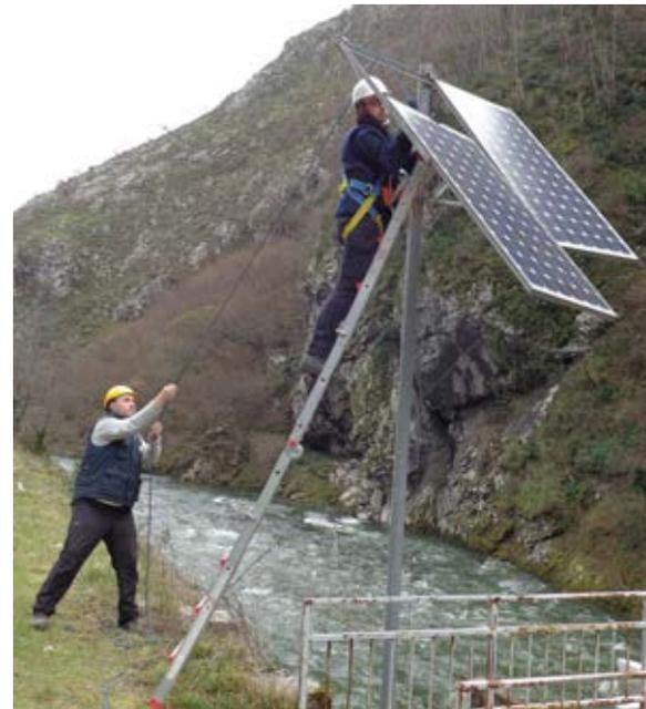
aplicaciones de intercambio de información con otras administraciones, concesionarios y Dirección General del Agua. En el 2015 se ha realizado con éxito la sustitución de las antiguas estaciones SICE-Dragados por las nuevas estaciones "Microcom", que comunican vía GPRS a través de internet con el software "Zeus" en un servidor de la Confederación.
