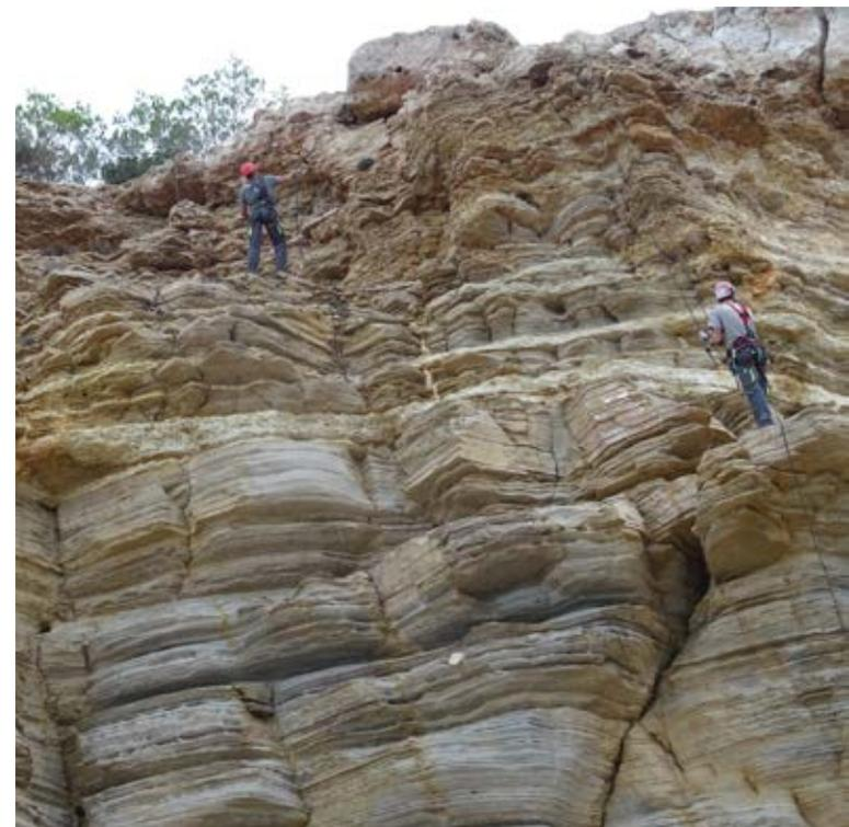
la cabecera de los taludes para el cable de línea de vida, trabajos de saneo, limpieza y retirada de materiales sueltos inestables por personal especialista mediante técnicas de escalada: se han retirado bloques, piedras, cuñas y lajas que se encontraban inestables. También se han retirado árboles y arbustos enraizados en grietas, que podían provocar la extrusión del bloque.
