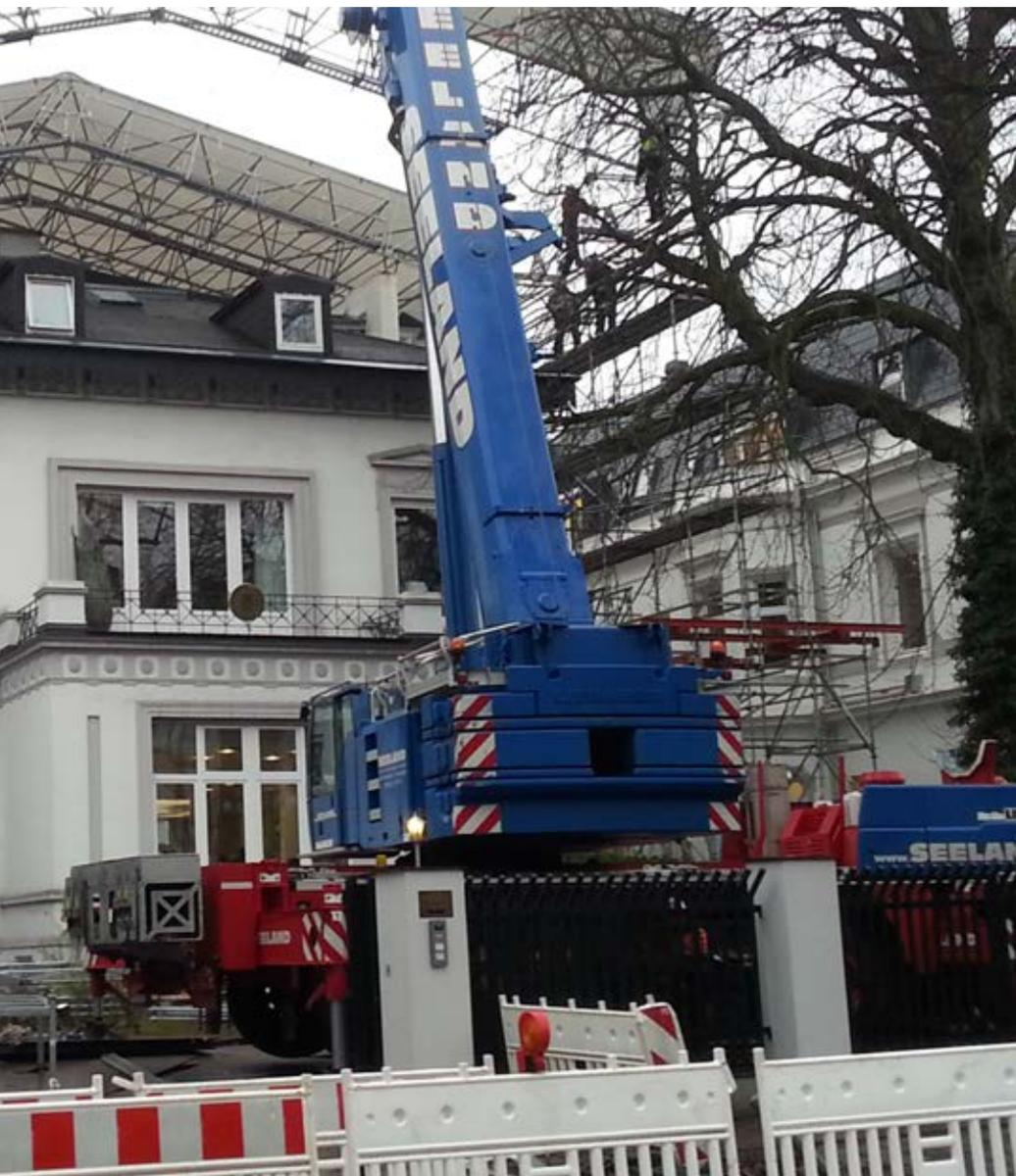
desmontaje de una cubierta provisional para proteger el edificio del consulado general de España en Hamburgo.
