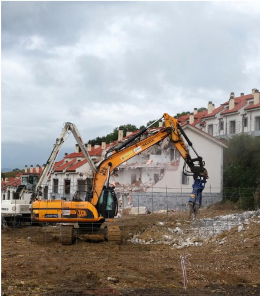
apeo de elementos que pudieran suponer algún peligro de desmoronamiento. Tras la demolición, se procedió a la clasificación de los escombros, retirándose a gestor autorizado los plásticos y ferralla, y procediéndose a la molienda de los inertes (cementos, hormigones, cerámicos, etc.), que se incorporaron a los materiales a utilizar en la restauración ambiental de la zona.
