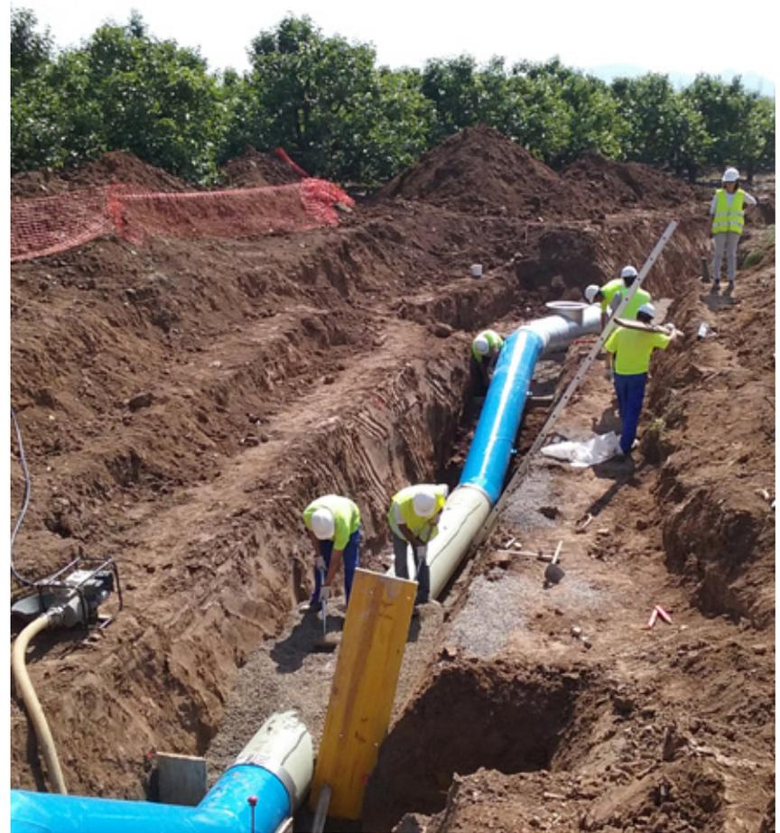
han instalado un total de 4.500 ml de tubería de PRFV, de diámetros 600, 700 y 800 mm, y de PVC-O DN 400 mm, con sus correspondientes válvulas de cierre, ventosas trifuncionales y desagües, alojándose en arquetas de hormigón. Para la comunicación del centro de control con todo el equipamiento de control ya ubicado en los edificios de cabezales, se han instalado 5.200 ml de cable de fibra óptica, con los correspondientes dispositivos de red y antenas.
