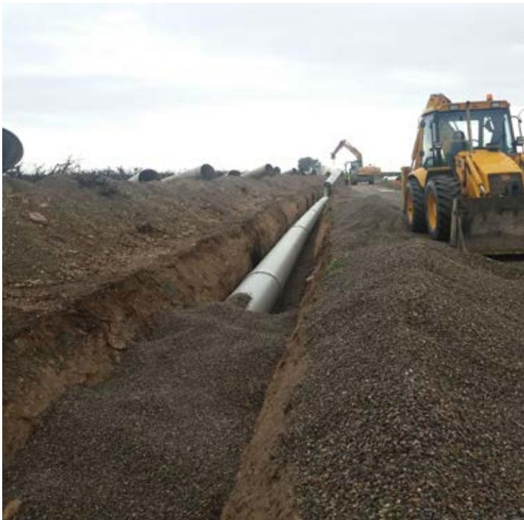
Proyecto consistente en la reposición de la tubería existente de PRFV por otra de igual material, diámetro y timbraje, realizando la excavación, desmontaje y extracción del tubo existente, su retirada a lugar de acopio, la instalación de la nueva tubería de PRFV con sus piezas especiales, y la reposición de servicios afectados en fincas y otros.
