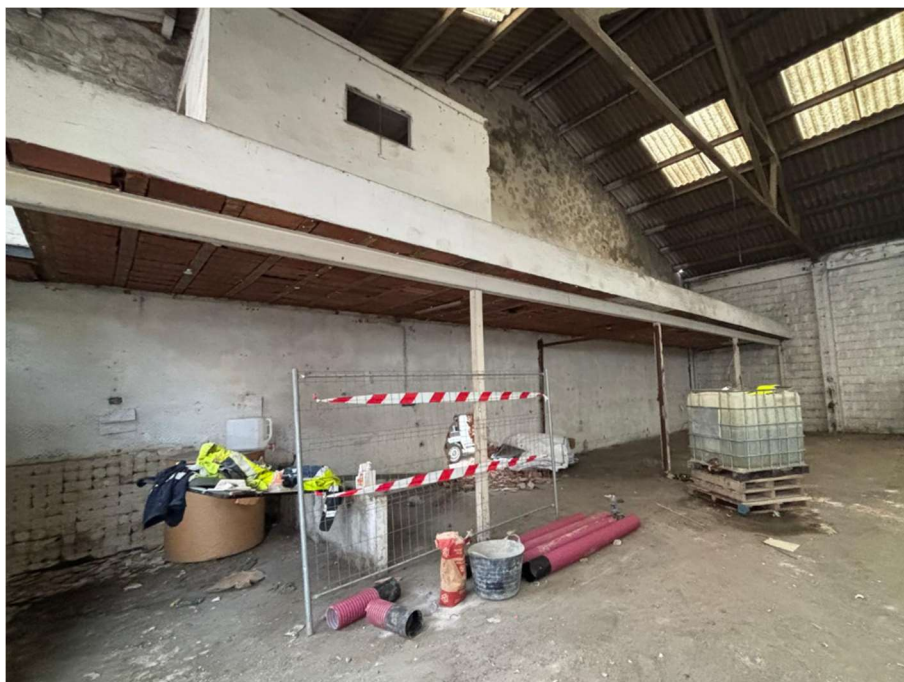
Vigas y pilares metálicos
