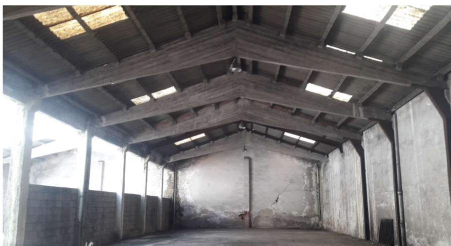
Perfiles, cerchas y correas metálicas
