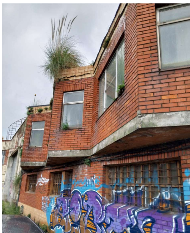
Rejas correspondientes a 13 ventanas
