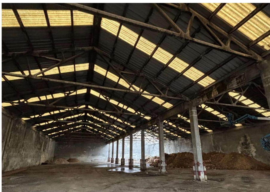
Cubierta de chapa metálica (1.600m 2 )
