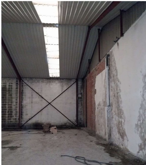
Estructura de perfiles y cubierta de chapa metálica (415m 2 )
