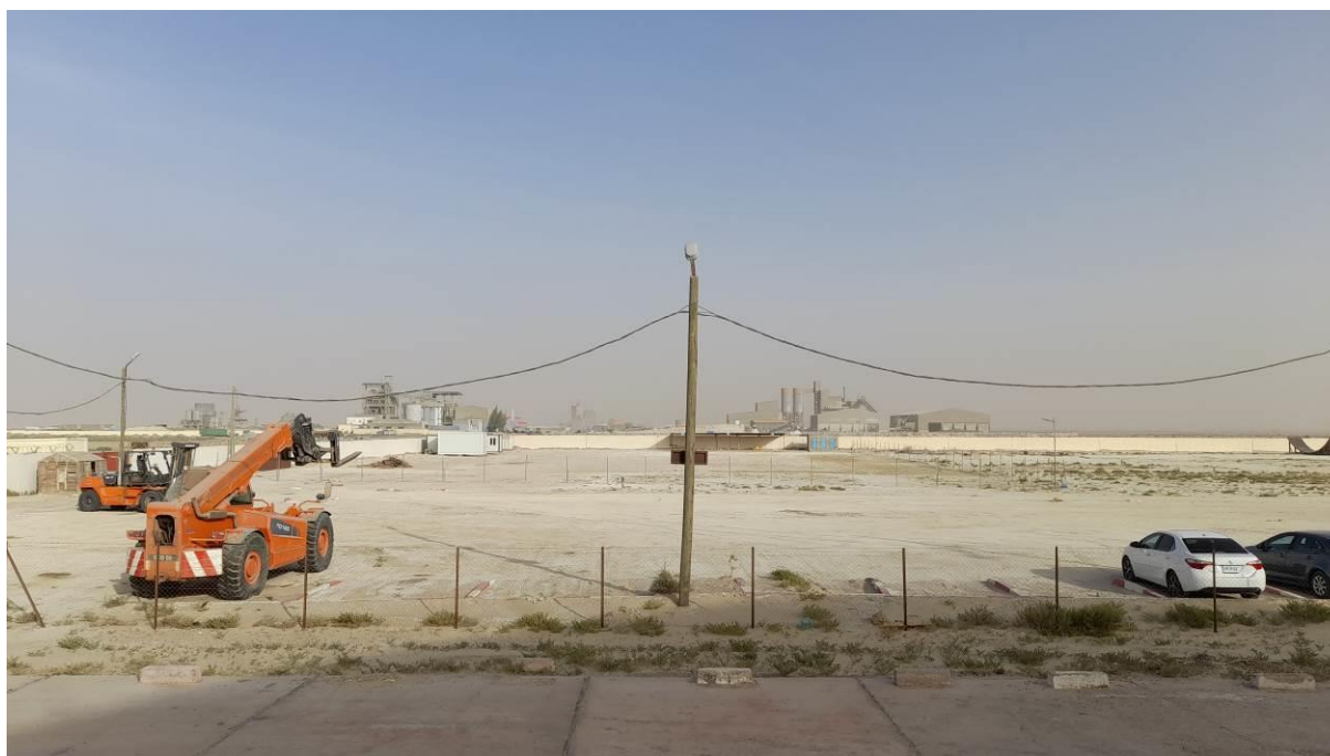
Figura 4 – Vista general zona ampliación
