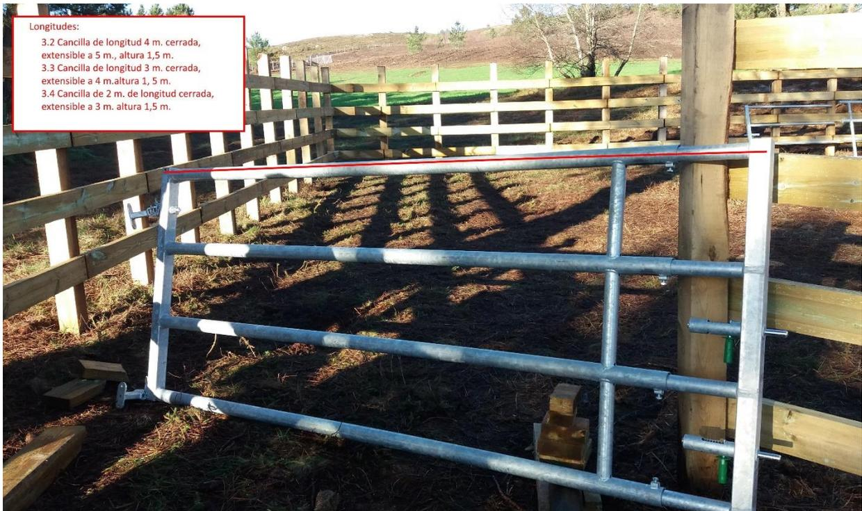
3.2;3.3 y 3.4 Cancilla metálica extensible de varios anchos y 1,5 m. de altura fabricado en 4 tubos galvanizados horizontales de 60 mm.incluso postes de sustentación de acero galvanizado # 100x100 mm y 2,2 metros de alto, herrajes y cerrojos. Suministrado en obra según cuadro de distribución.
