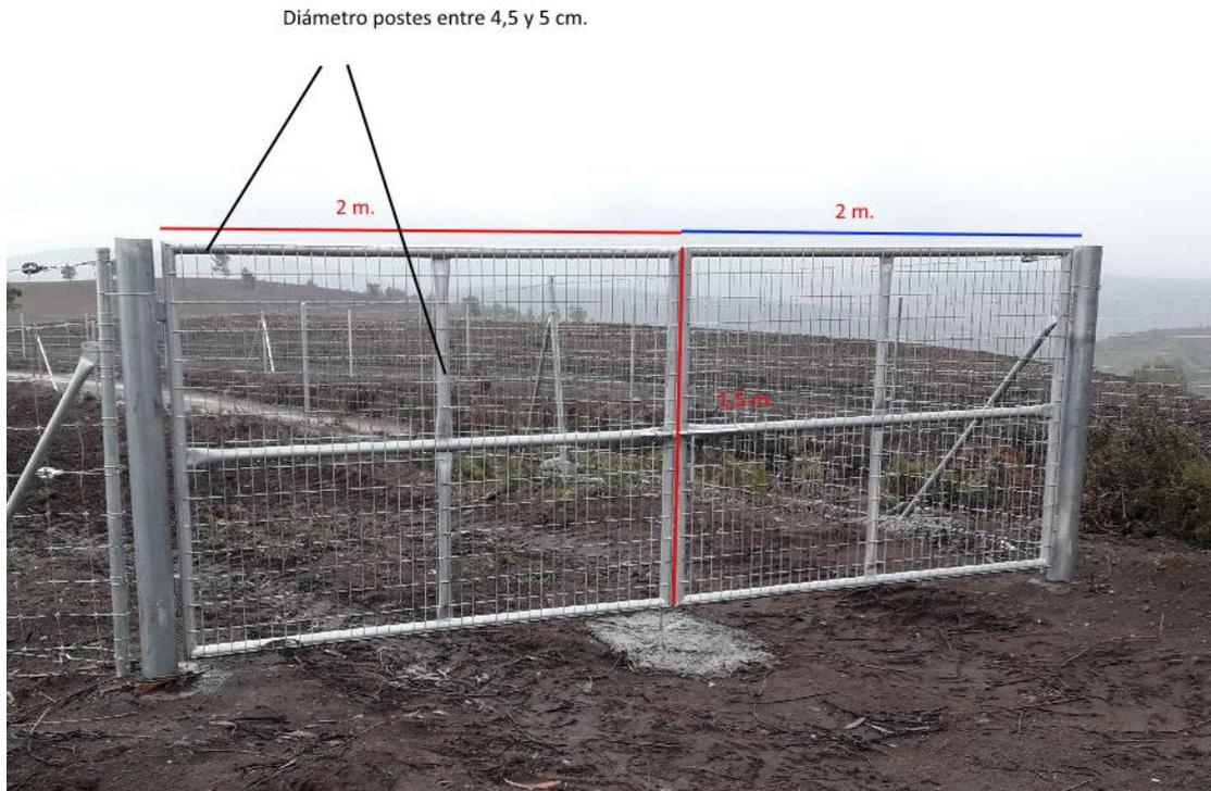
2.1.- Cancilla galvanizada recta de perfil galvanizado de diámetro 48x1,5 mm. con malla electrosoldada 100x50x4, de 4 m. de ancho y 1,5 m. de alto, en dos hojas. Incluidos postes de sujeción, bisagras, cerrojo galvanizado y pasador al suelo. Suministrado en obra según cuadro de distribución.
