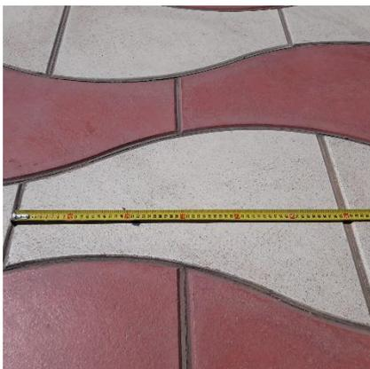
(Foto losa tipo ola existente de 60 cm de largo y anchura variable entre 19 cm y 43 cm)
