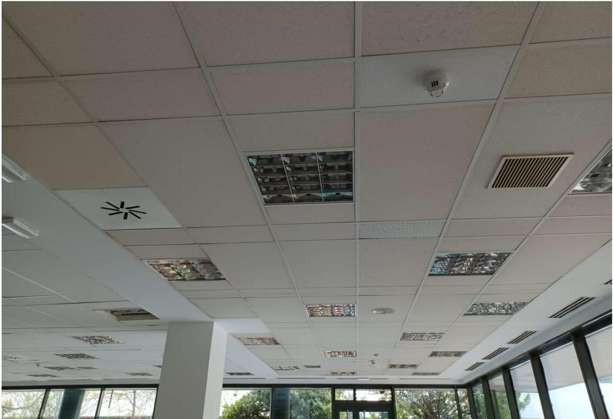
(UD.) Suministro e instalación en cuartos racks y vending de rejilla de retorno para techos modulares, construida con láminas paralelas fijas e inclinadas, unidas entre sí por tubos de aluminio, de 600x600 mm, con acabado en blanco.
