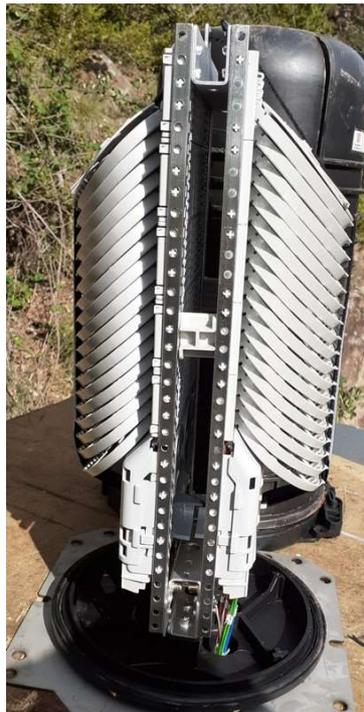
*Ilustración 3: Ejemplo de bandejas instaladas en la caja de empalme*
