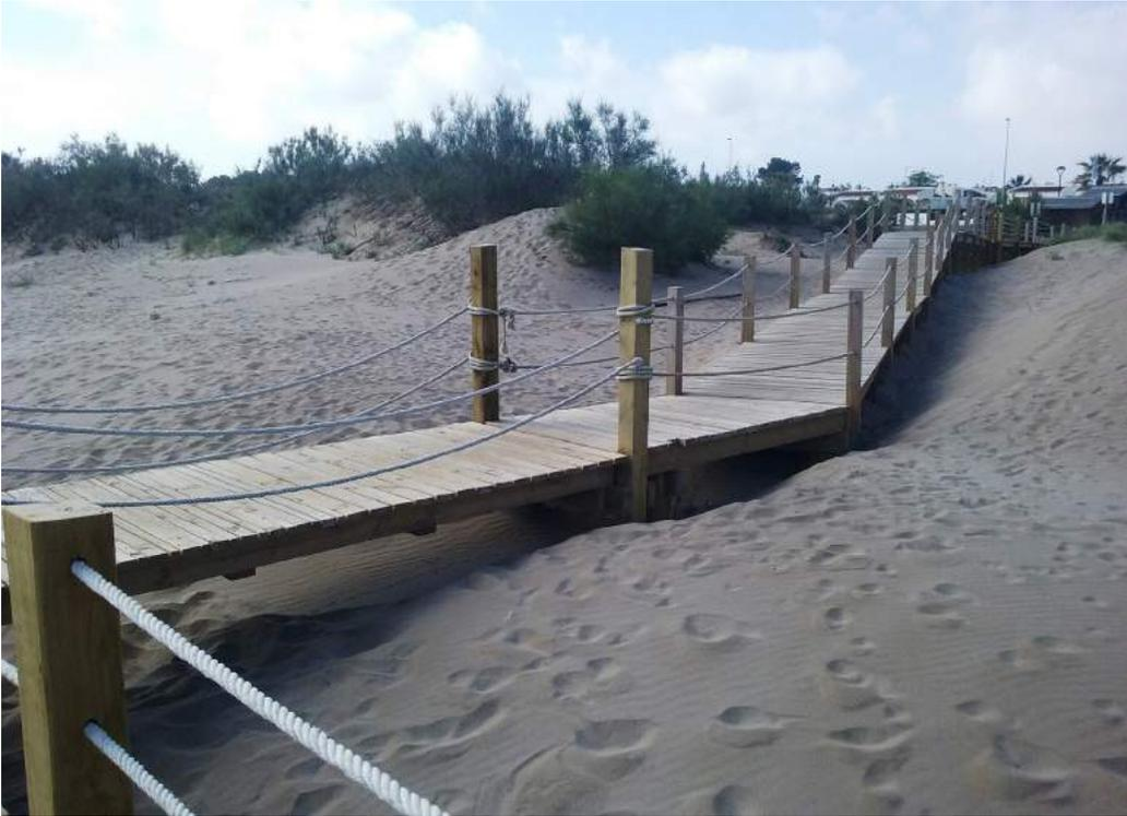
acero inoxidable pasantes de métrica 12. Sobre esta estructura descansan seis correas longitudinales de sección 20x10 cm que sirven de apoyo a la tarima de madera de sección 14,5x4,5 cm, que se fija mediante tornillería en acero inoxidable a las correas longitudinales.
