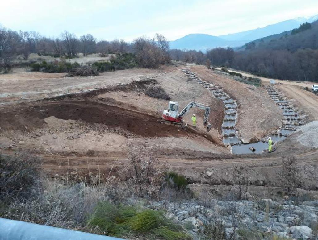
De esta actuación destacan los trabajos de mejora de la conectividad longitudinal del embalse de Santa Lucía, consistentes en la construcción de un canal naturalizado situado en la margen izquierda del embalse, que permitirá eliminar el efecto barrera que provoca la presa en los movimientos de dispersión de la población del desmán.
