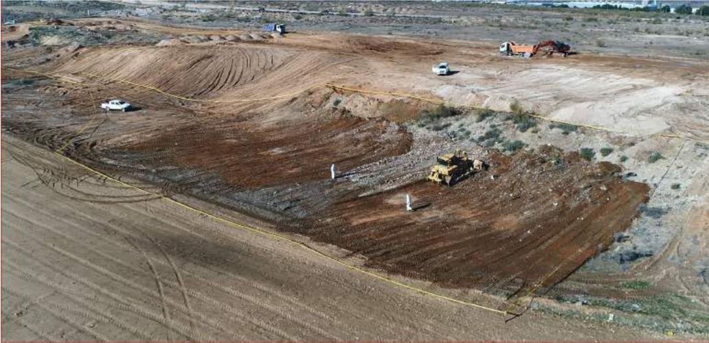
posterior impermeabilización con una lámina de polietileno de 2 milímetros de espesor, más un geocompuesto drenante que facilite la evacuación del agua de lluvia. Toda la superficie afectada se ha cubierto con 0,5 metros de espesor de tierra para favorecer el desarrollo de vegetación, y se ha vallado. También se han recogido, puntualmente, trozos dispersos de amianto de mayor tamaño, gestionados según el plan de trabajo de amianto aprobado mediante un gestor autorizado.
