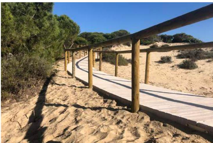
Se está realizando la reparación y sustitución de elementos degradados en seis pasarelas de acceso a la playa, dentro del Paraje Natural de Enebrales de Punta Umbría, en Huelva. En tres pasarelas se sustituye el entarimado de madera por módulos prefabricados de hormigón imitación madera, y en las otras tres se repara la estructura de madera existente. Se reparan y construyen talanqueras de madera de protección y se repone la señalización.
