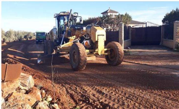
acondicionamiento de firmes, fundamentalmente bases y subbases granuladas y pavimentos de hormigón, y actuaciones lineales de drenaje, principalmente excavaciones y revestimiento de cunetas. También se han realizado actuaciones puntuales de drenaje, como obras de fábrica para pasos de agua con sus arquetas y embocaduras, pasos salvacunetas o badenes además de otras actuaciones puntuales como muros de hormigón, mampostería o gavión, y escolleras.
