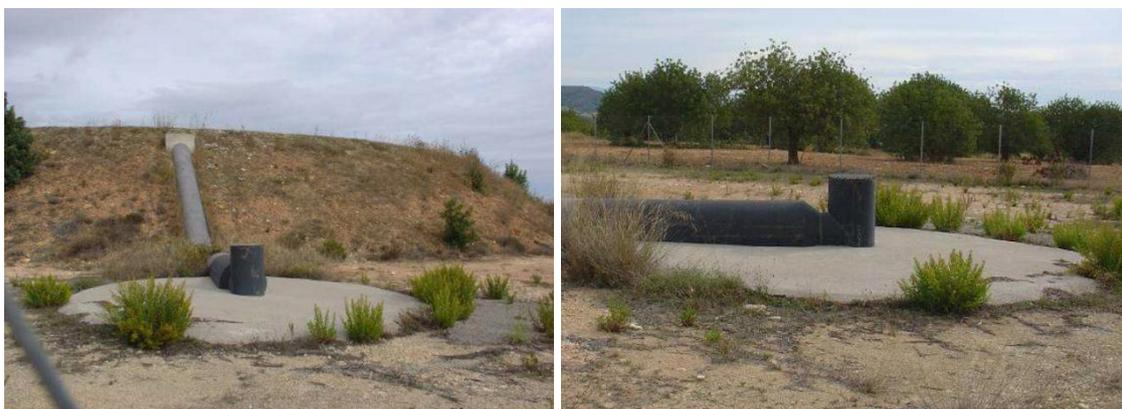
Figuras 63. Detalle del cabezal de inyección del sondeo Arnachos 1, en Chulilla, Valencia. Fotos por cortesía de J.M. Montes.
