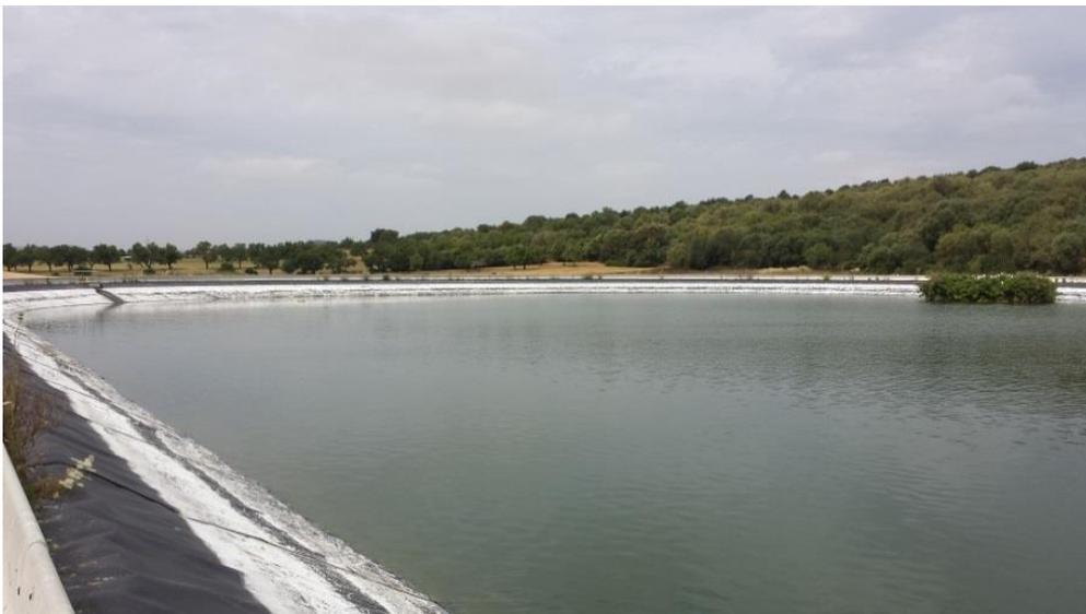
Figura 28. Precipitado de carbonato cálcico en las orillas de la balsa de *Ariany*. Los cristales provocan el blanqueo de las lonas de la balsa, convirtiéndose éstas en un buen indicador de estos procesos. Dicha precipitación puede ser puntualmente ventajosa para los sistemas de conducción de agua, ya que conlleva una bajada en la concentración de carbonato cálcico dentro de la red.
