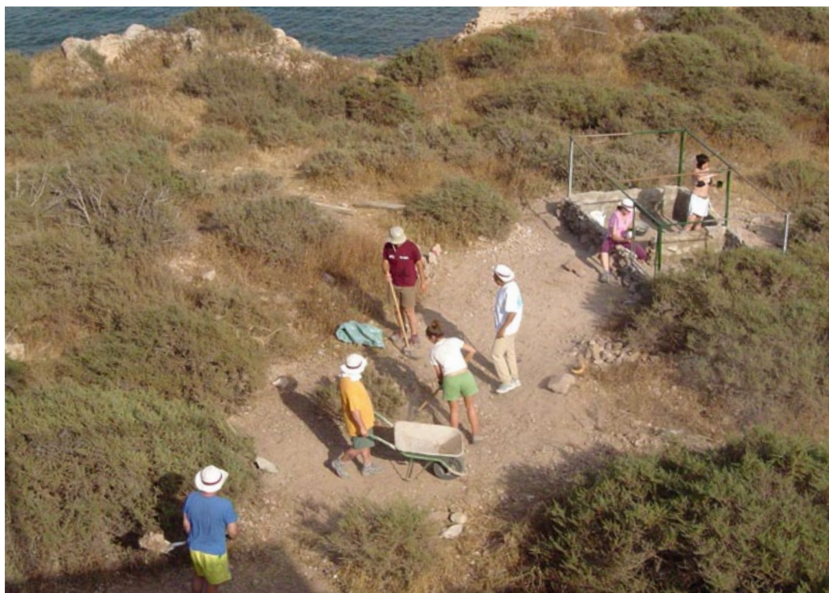
Construcción de un terrario en el Refugio Nacional de Caza de las Islas Chafarinas.
