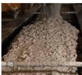
utiliza cemento con alta estabilidad a la agresión química, del tipo CEM III/A 42,5/SR.
