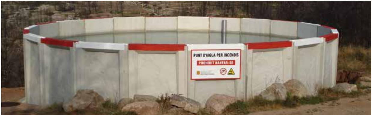
La clave de estos depósitos se basa en el montaje de módulos de hormigón armado en el que se emplean dos tipos de soluciones según sea el tipo de panel elegido:
