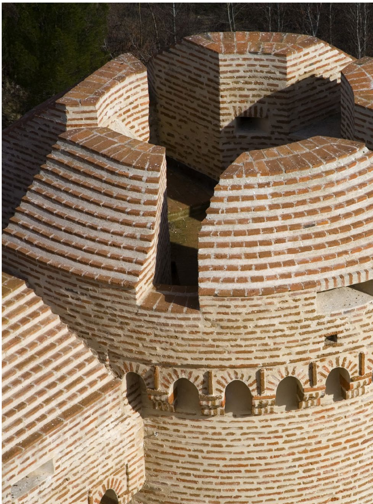
Reforma y rehabilitación del castillo de Arévalo, Ávila.
