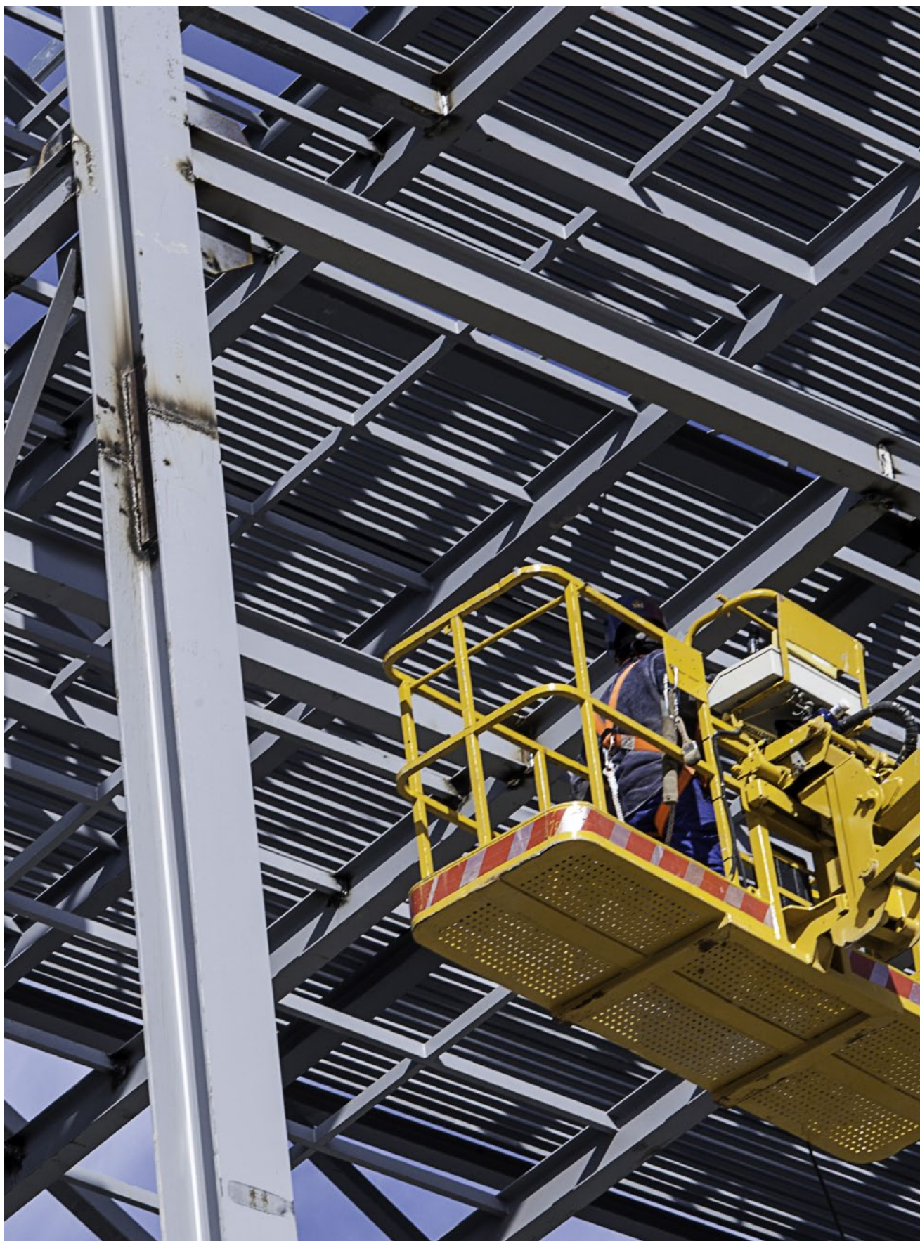
Reconstrucción del Recinto Ferial de Santa Quiteria, Lorca. Ejecución de caja escénica para el auditorio.
