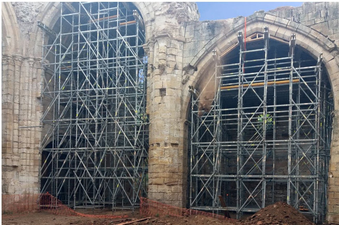
Figura 39. Obras de reparación y consolidación del monasterio de Santa María de Bonaval en Retiendas, Guadalajara.
