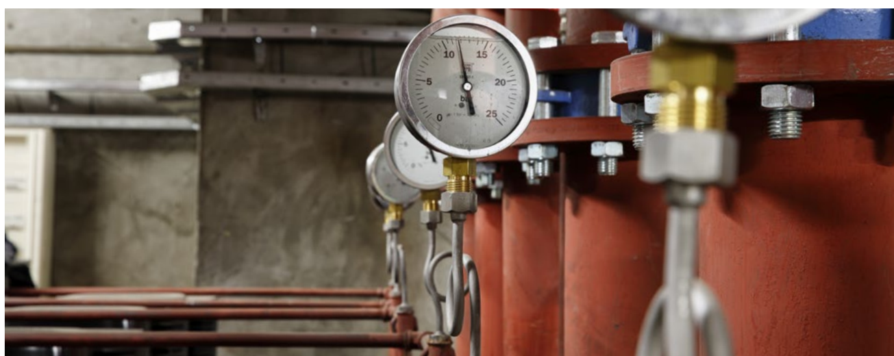
Figura 44. Nuevas instalaciones en la rehabilitación de la sede central del Ministerio de Economía y Competitividad.
