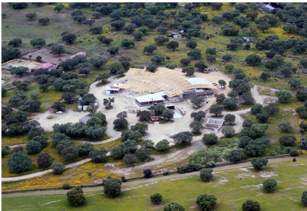
Figura 41. Ejecución del centro de visitantes del Parque Nacional de Monfragüe. Malpartida de Plasencia, Cáceres.
