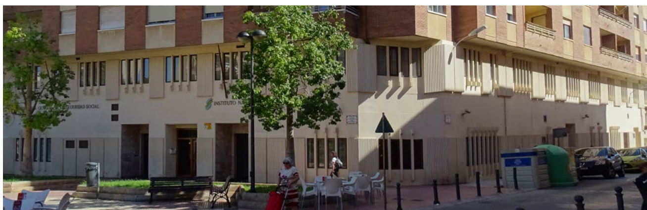
Figura 50. Proyecto de adecuación de la antigua sede de la Dirección Provincial de la TGSS de Castellón.
