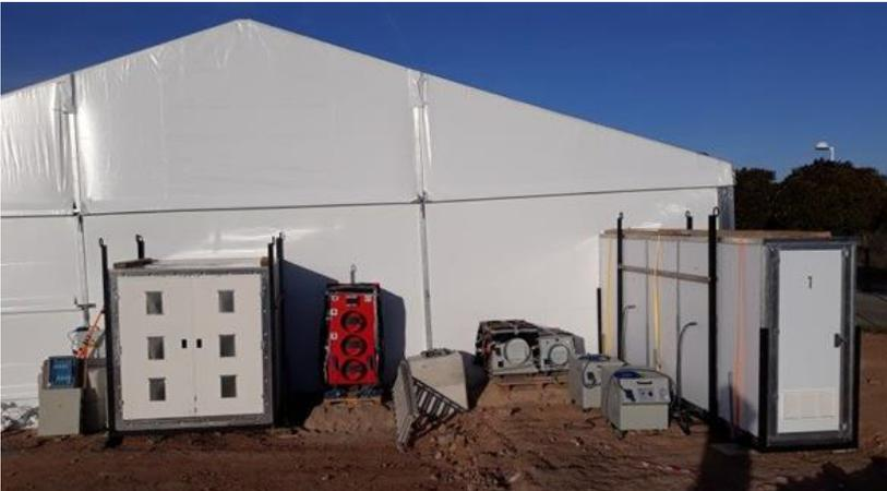
Montaje de esclusa de materiales, unidad de descontaminación y equipos de depresión
