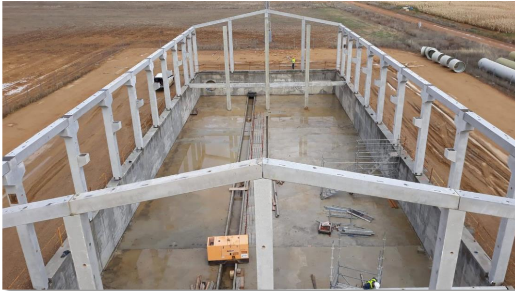
Estructura de la estación de bombeo en Gordaliza del Pino (León) – Sector VIII Payuelos
