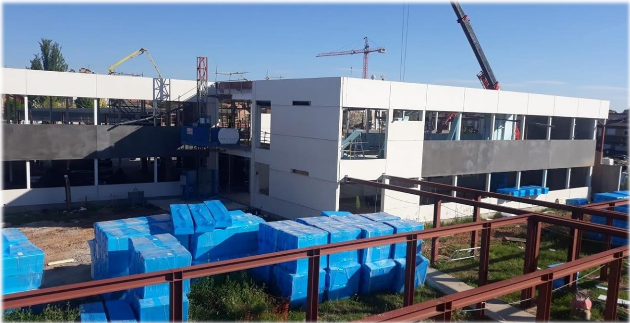
Montaje de paneles prefabricados en un colegio en Alovera, Guadalajara
