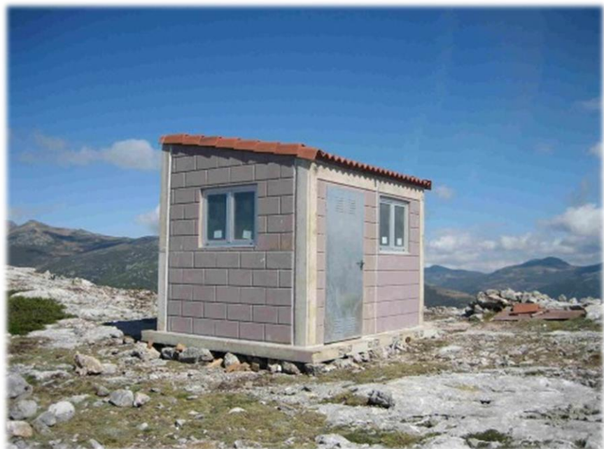
Caseta prefabricada de vigilancia de incendios en Pico Santa Lucía, Montaña Palentina
