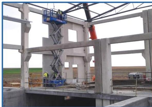
*Piezas de hormigón prefabricadas en La Planta*
