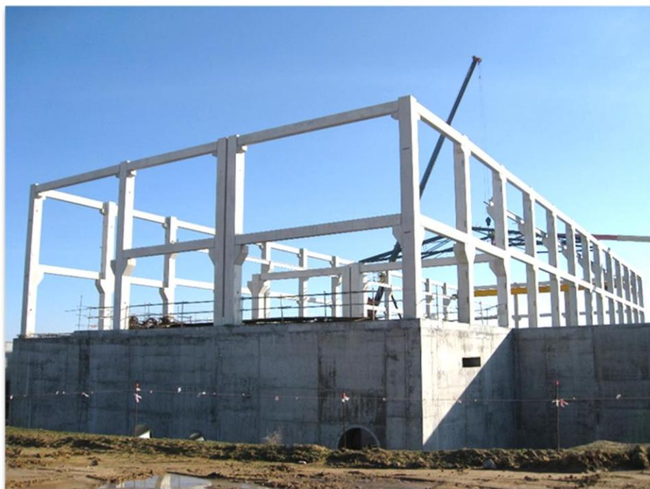
*Piezas prefabricadas de hormigón en la Planta*
