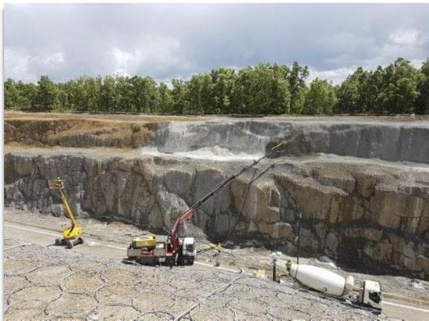
*Construcción para la reparación de taludes en desmontes de la línea de alta velocidad Madrid- Galicia, a su paso por Zamora.*
