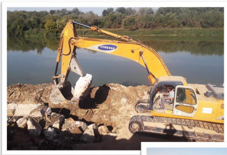
Obras de emergencia, para reparación de estructuras de defensa ante inundaciones. (Osera de Ebro)
