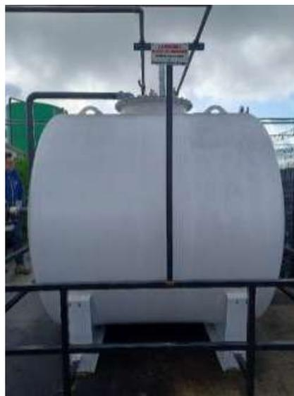
*Nuevo depósito de combustible de 5.000 l, exterior, con doble pared, con nº IP-32000401, instalado en 2023.*
