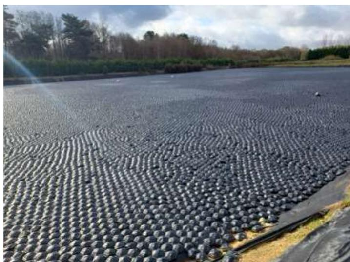
Balsa de riego cubierta con módulos flotantes aislados fabricados en HDPE. Con esta medida, vinculada a uno de los objetivos ambientales del año 2023, se pretendía disminuir las pérdidas de agua por evaporación en el área de cobertura y mejorar la calidad del agua de riego, por la reducción de la concentración de microalgas al disminuir la entrada de luz, minimizando así, además, la necesidad de control mediante tratamientos químicos.
