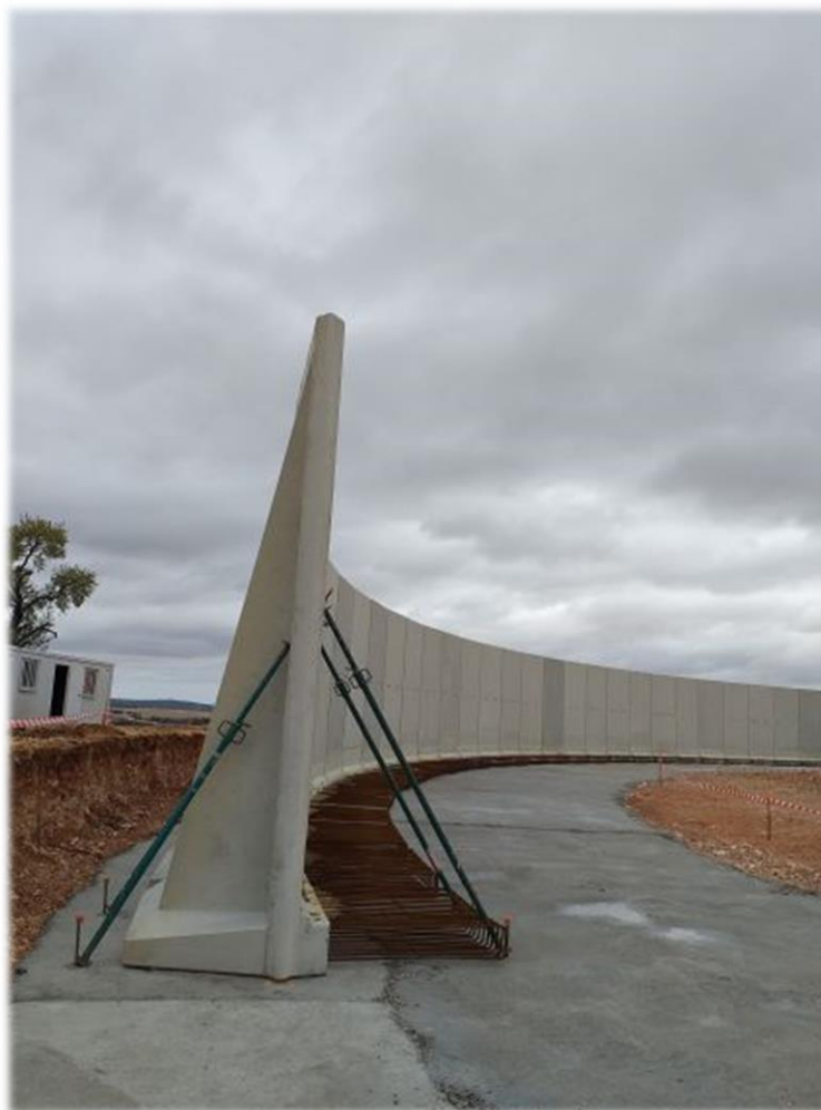
Montaje de depósito prefabricado en Zorita, Salamanca
