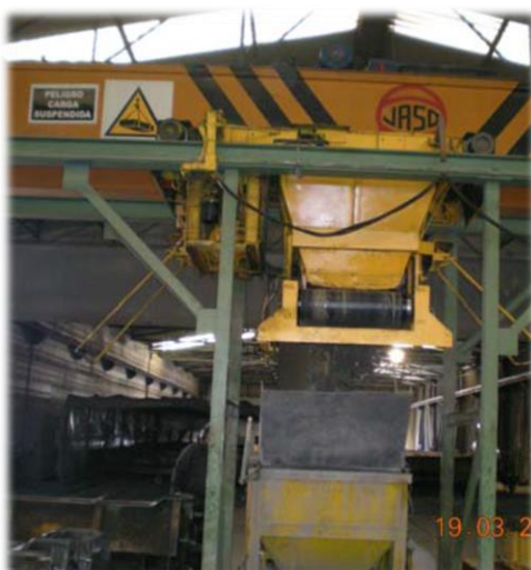
Descarga del hormigón en los moldes
