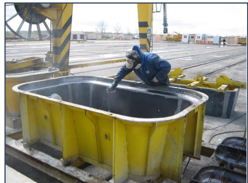
Repaso y limpieza de moldes
