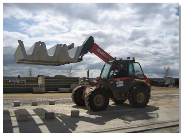
Transporte de piezas a acopio
