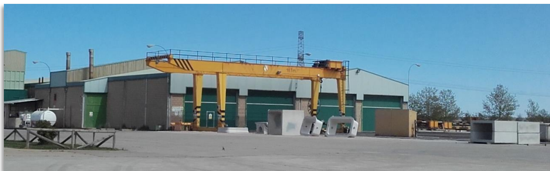
Vista de la Planta de prefabricados de hormigón
