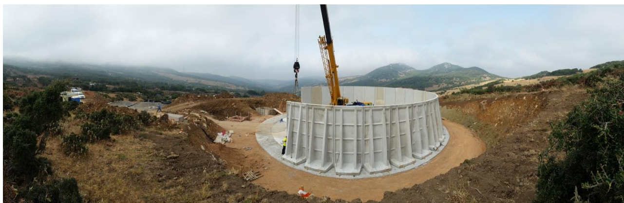
Construcción de depósito de piezas prefabricadas en Tarifa
