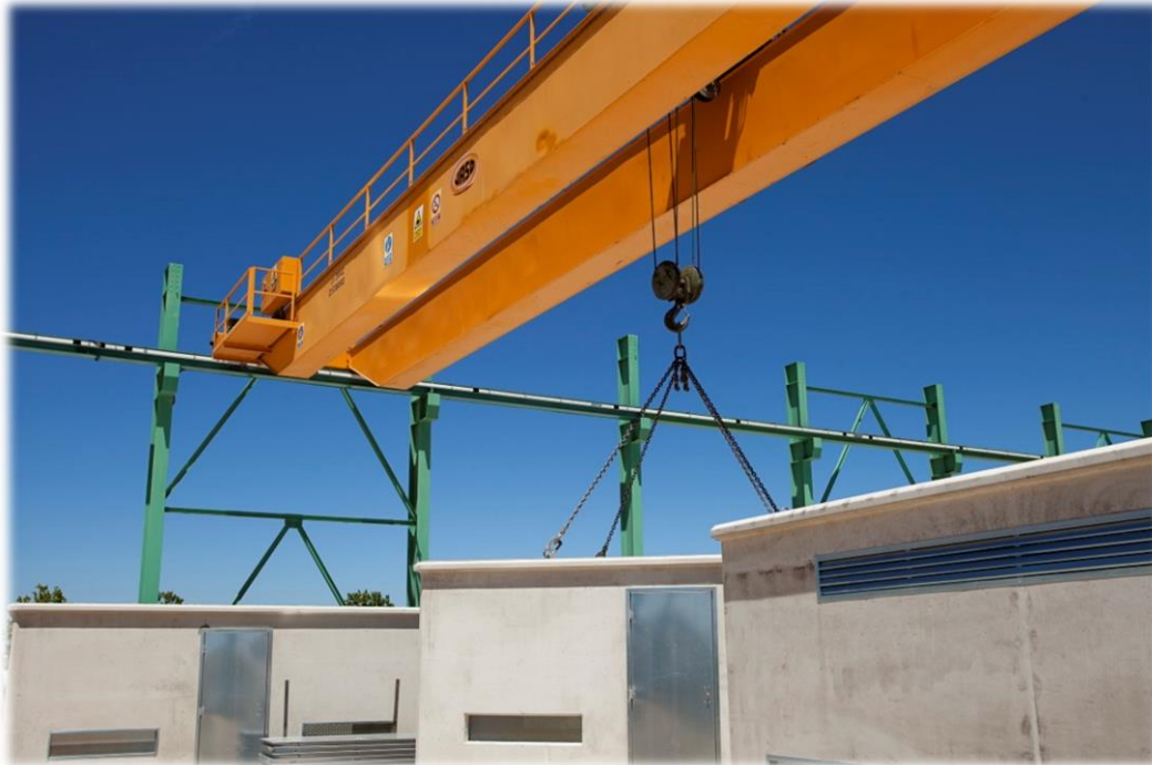
Traslado de casetas prefabricadas
