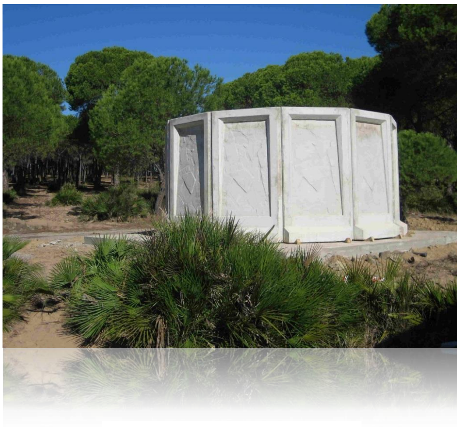
Depósito contra incendios
