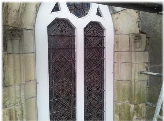
Colocación de vidrieras en la capilla del Parador "Hostal de los Reyes Católicos" (Santiago de Compostela).
