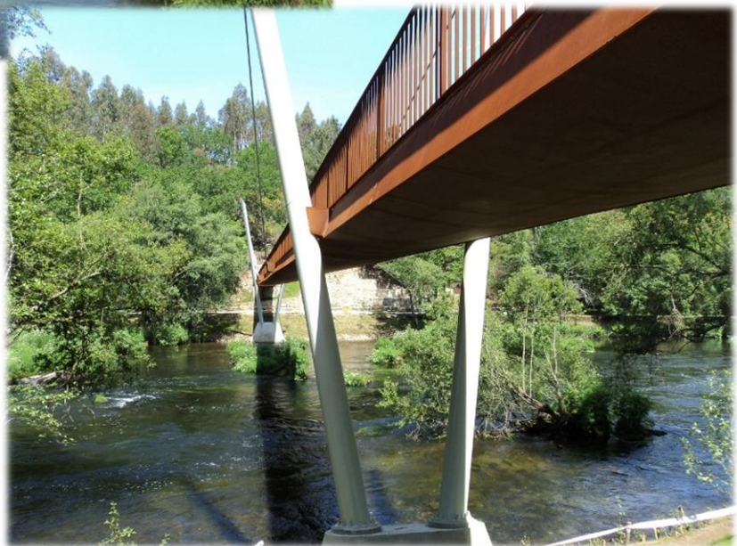
Instalación de senda peatonal en el LIC Sistema Fluvial Ulla Deza
