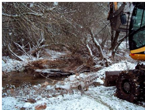
Mantenimiento de cauces en Torrelaguna Cuenca del río Tajo
