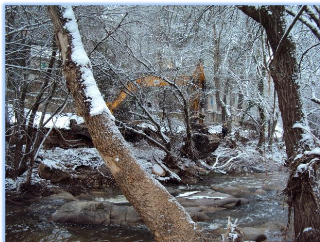
Mantenimiento de cauces en Torrelaguna Cuenca del río Tajo
