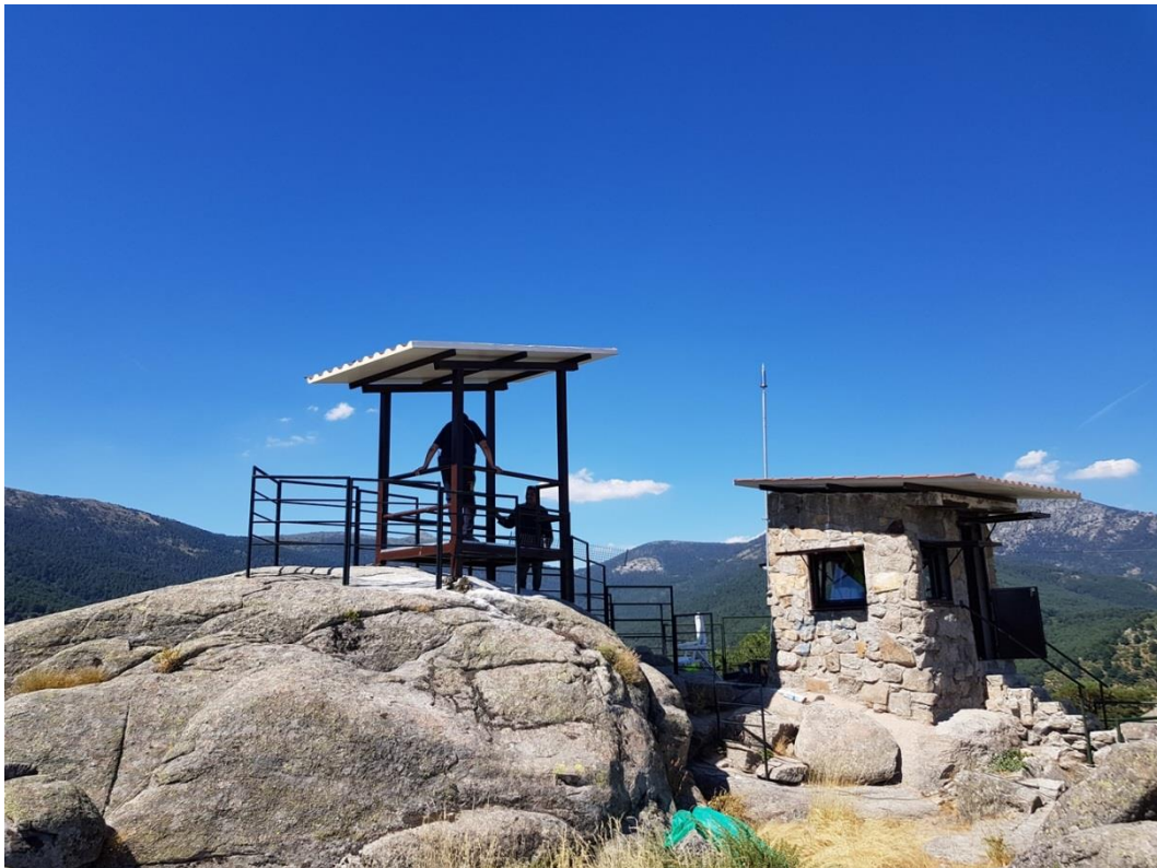
Rehabilitación de puesto de vigilancia de la Comunidad de Madrid
