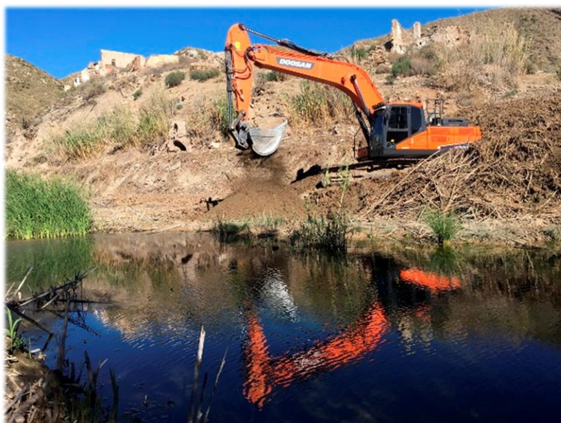
Actuaciones de restauración del tramo final del río Adra
