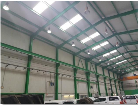
Parque de maquinaria de Sevilla
