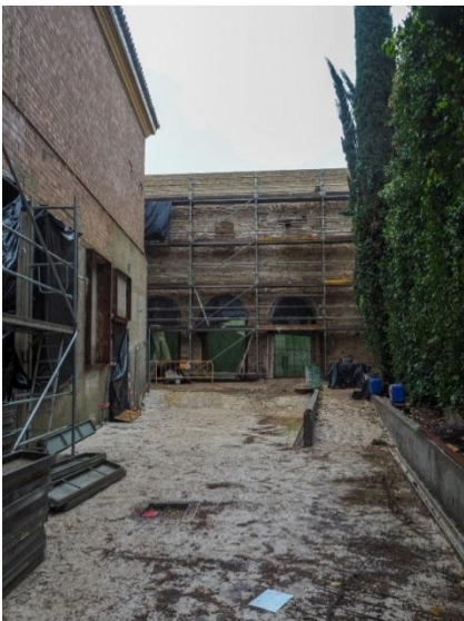
Obras de restauración del Palacio de Congresos de Córdoba. Zona del adarve.
