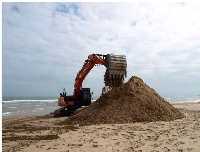
Obras de emergencia de reparación de daños producidos por los temporales
