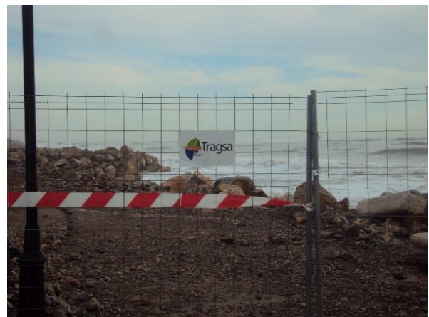
Obras en paseo marítimo
