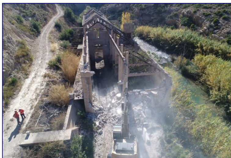
Adecuación Cuenca Hidrográfica del Corindón Vista de la antigua central hidroeléctrica en ruinas
