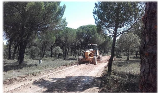
Mejora de camino en Monte de Utilidad Pública
