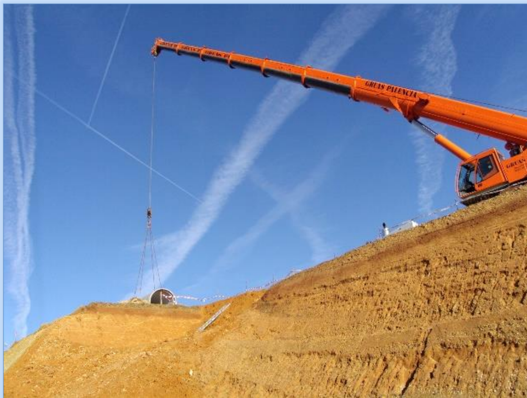
Mejora y modernización del regadío Canal de Toro-Zamora. Colocación de tubería
