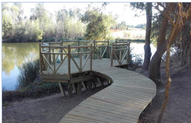
Mantenimiento Reserva Natural Riberas de Castronuño-Vega del Duero. Mirador de la Abadesa
