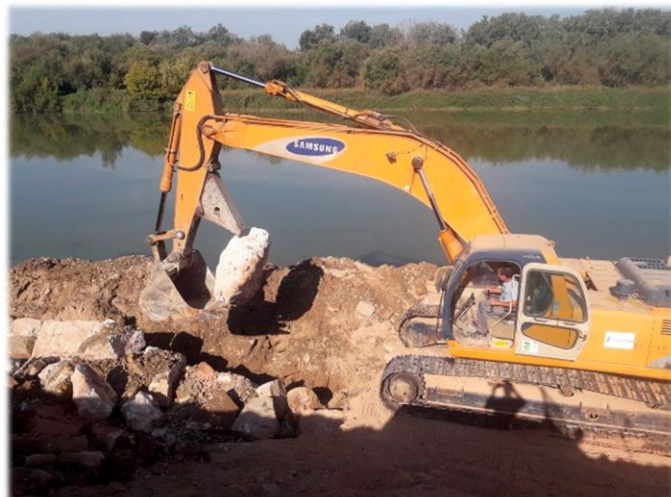
Reparación de estructuras de defensa ante inundaciones, Osera de Ebro
