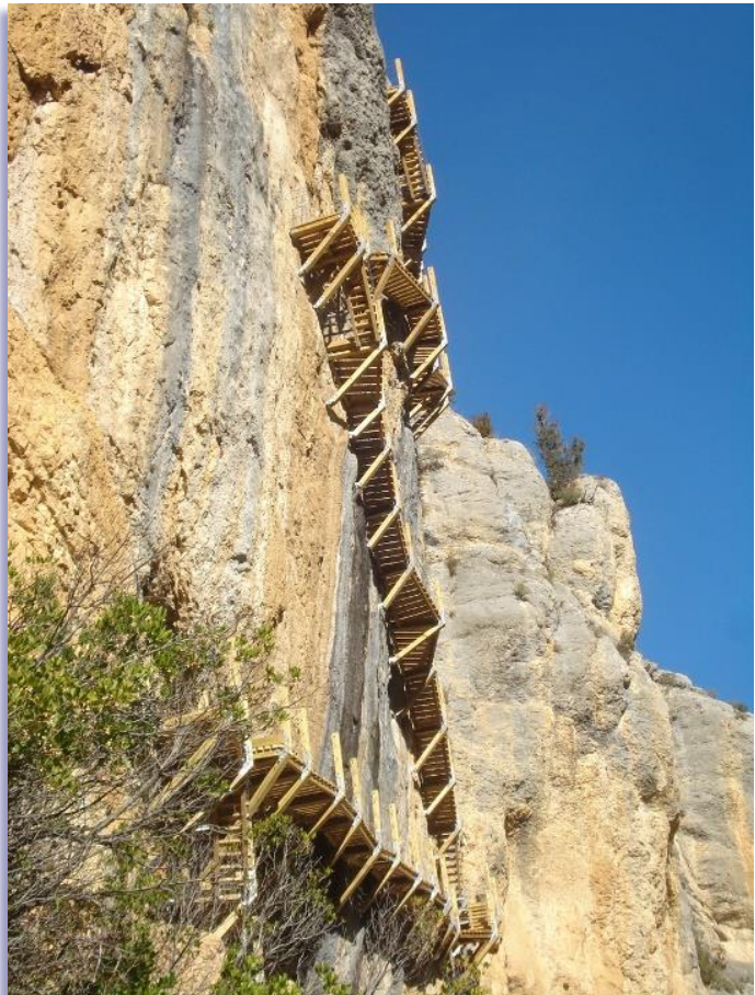
Camino natural de acceso Mont-Rebei, Huesca. Pasarela de madera adosada al farallón instalada.
